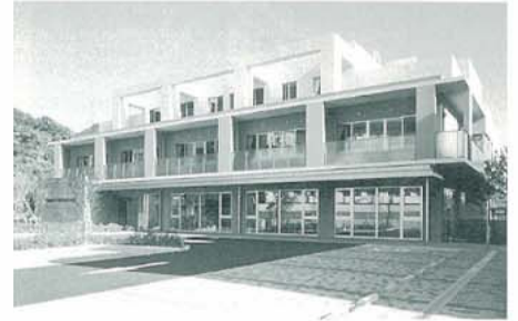
新須磨リハビリテーション病院 新築工事(兵庫県)
