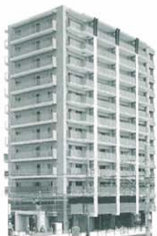
(仮称) 粕壁東1丁目 マンション新築工事(埼玉県)
