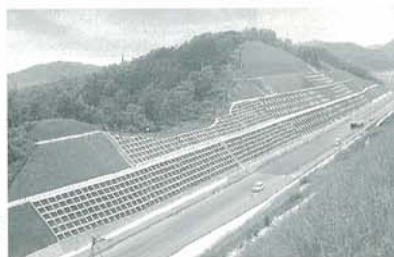
日本海東北自動車道 神沢工事(秋田県)
