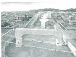
平成18年度北勢BP さざらい北高架橋下部工事 (三重県)
