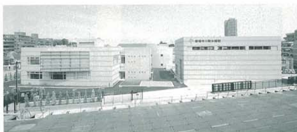
善福寺川取水施設建築工事(東京都)
