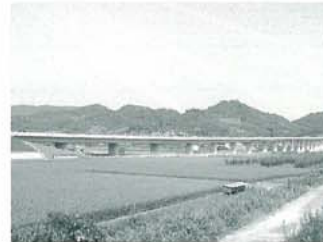
阪和自動車道南部高架橋工事 (和歌山県)
