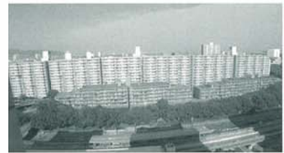
エバーグリーンポートアイランド 大規模修繕工事(兵庫県)
