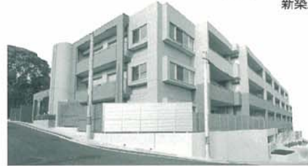
(仮称)雲雀丘花屋敷アインズ新築工事(兵庫県)
