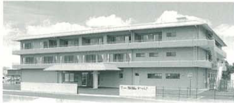
(仮称) 葛城介護老人保健施設新築工事 (奈良県)
