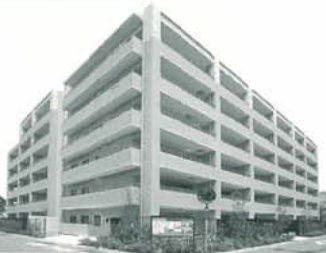
武庫之荘大蔵公園 アーバンライフ新築工事 (兵庫県)
