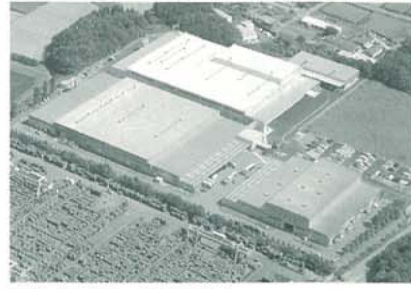
岐阜プラスチック工業(株) 福島工場新築工事 (福島県)
