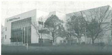
株式会社フクヨー神戸 工場改修工事 (兵庫県)
