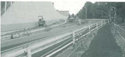
主要地方道三田後川上線歩道整備工事 (兵庫県)
