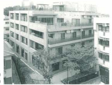
笹塚二丁目施設 (仮称) 建設建築工事 (東京都)
