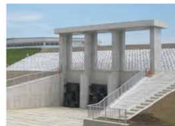
施工実績 発注者：国土交通省 関東地方整備局 用途：排水樋管 竣工年：2012年 所在地：栃木県
